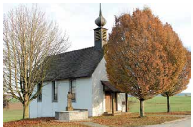
Bild Mitte links: Außenansicht
